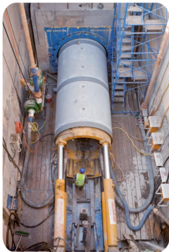
Pour minimiser les désagréments causés aux riverains et aux usagers de la voie publique, des micro-tunneliers ont été utilisés pour creuser les galeries souterraines des intercepteurs et la partie terrestre de l'émissaire marin. Ces appareils automatisés descendent ainsi à la profondeur souhaitée et creusent des tunnels sans ouvrir de tranchées, assurant ainsi davantage de sécurité et offrant un gain de temps indéniable.
