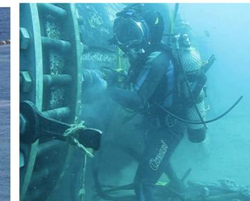
Raccordement par plongeurs
