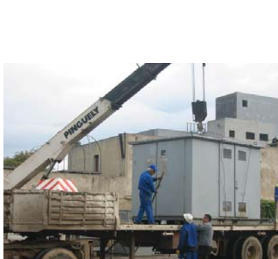
Cabine mobile en cours d'installation chez un client
