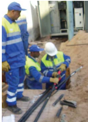
Raccordement d'une cabine mobile chez un client par des agents LYDEC
