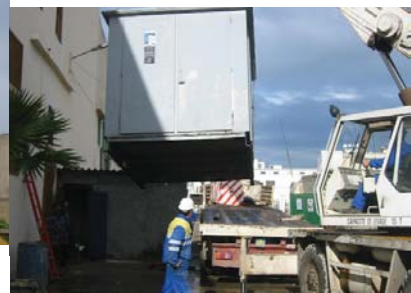
Cabine mobile en cours d'installation chez un client
