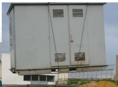
Cabine mobile en cours d'installation chez un client
