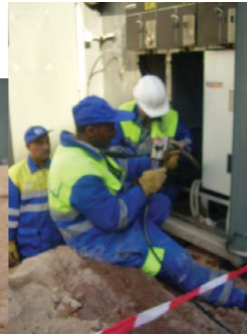
Raccordement d'une cabine mobile chez un client par des agents LYDEC
