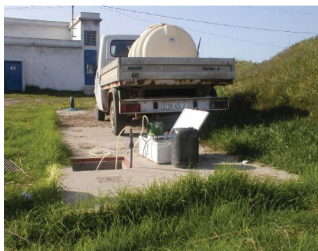
Camion LYDEC de désinfection des conduites d'eau potable
